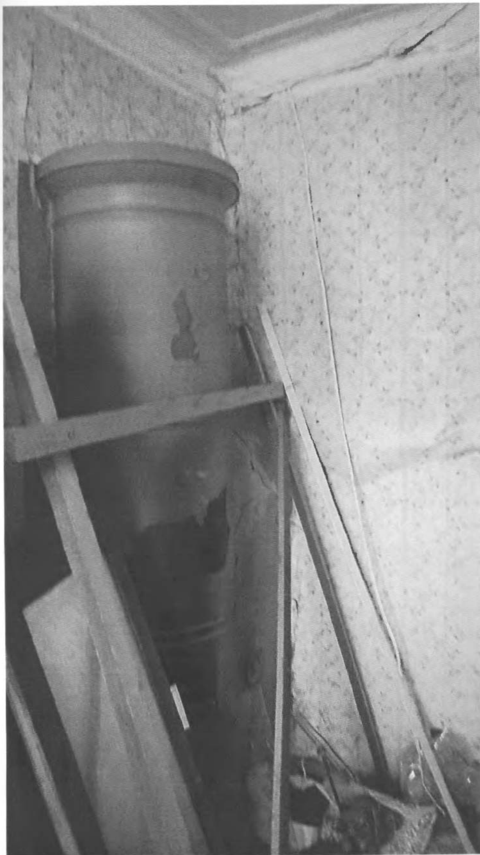
34. Сестрорецк, Дубковское шоссе, 1. 2 этаж. Печь в восточной части здания. Фото: М. И. Мильчик. 12.06.2013.
