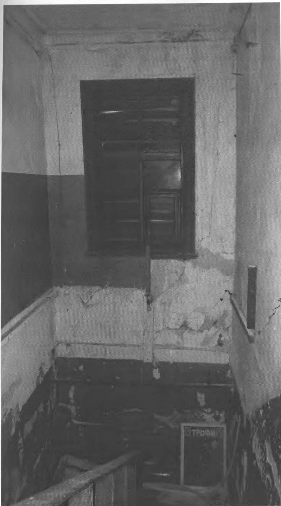
20. Сестрорецк, Дубковское шоссе, 1. 2 этаж. Лестничная клетка в юго-западной части здания. Фото: М. И. Мильчик. 12.06.2013.
