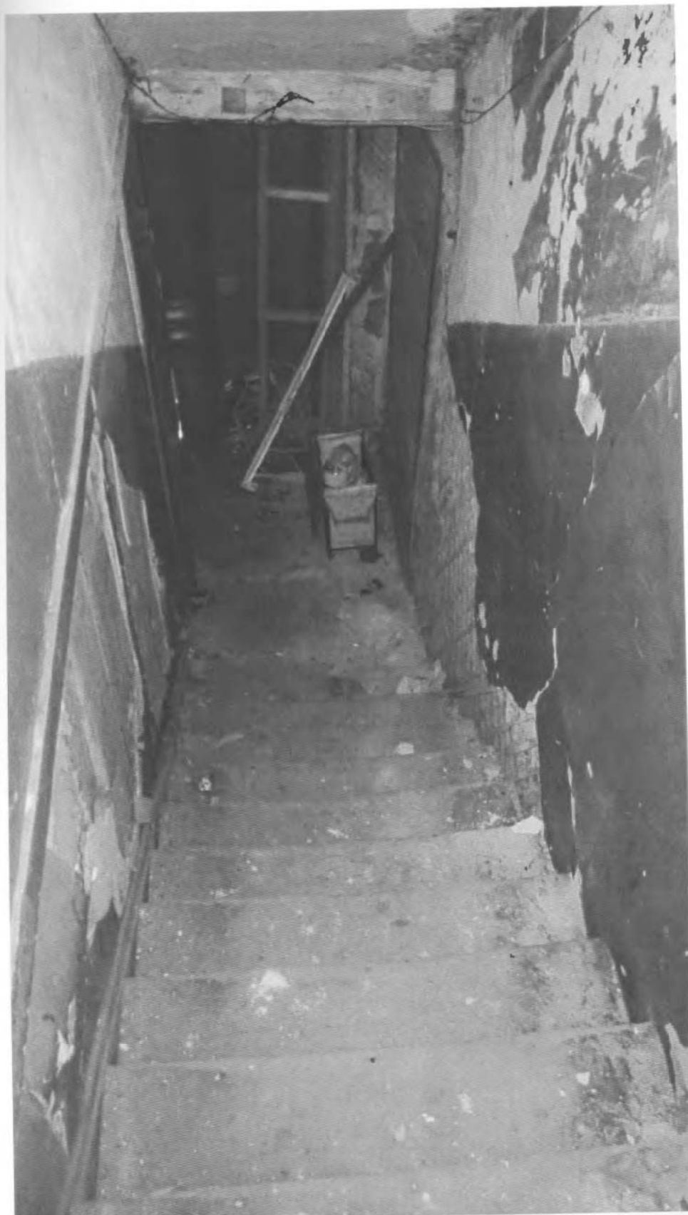
17. Сестрорецк, Дубковское шоссе, 1. 1 этаж. Лестница в юго-западной части здания. Фото: М. И. Мильчик. 12.06.2013.
