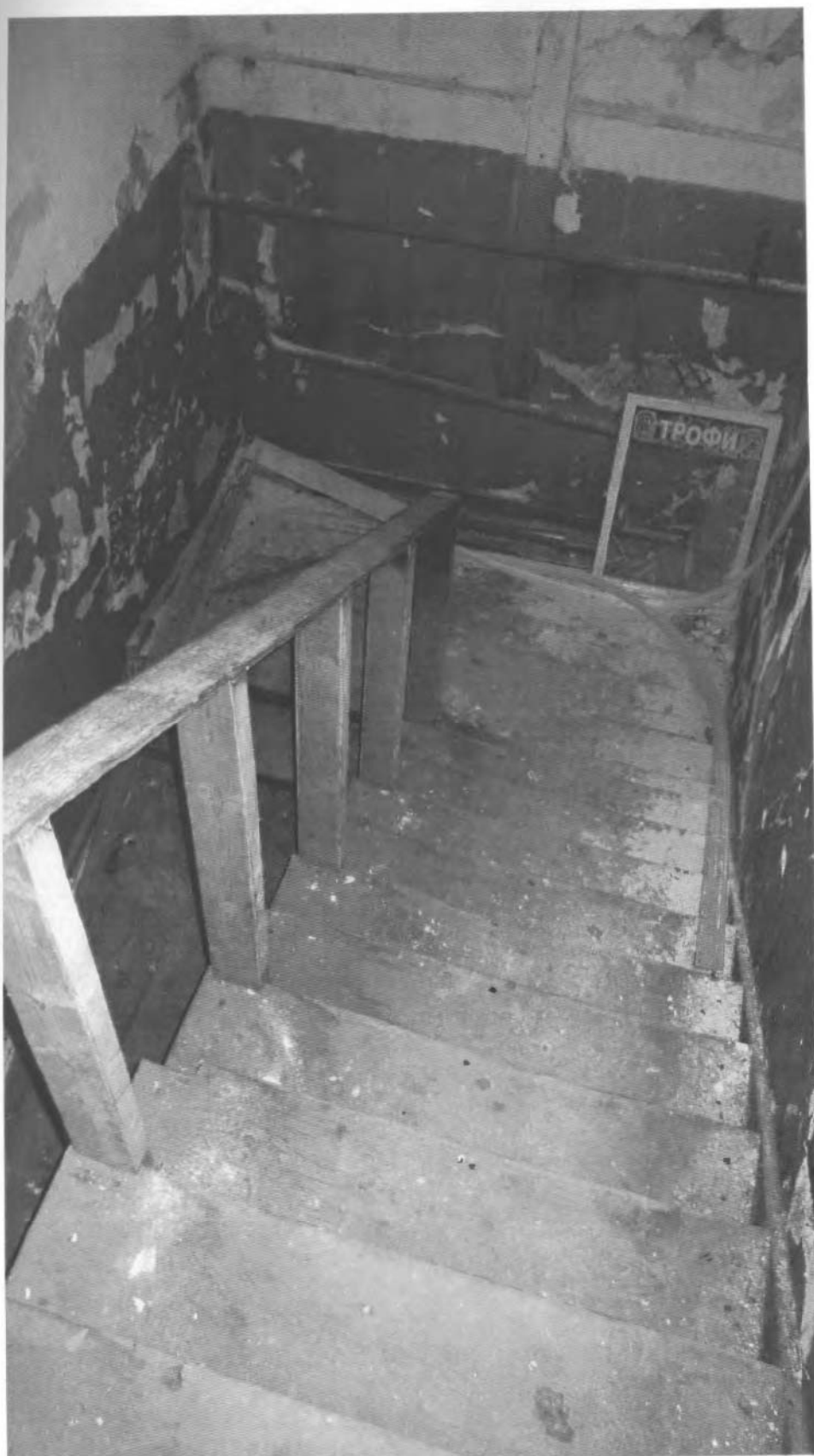
19. Сестрорецк, Дубковское шоссе, 1. 2 этаж. Лестница в юго-западной части здания. Фото: М. И. Мильчик. 12.06.2013.
