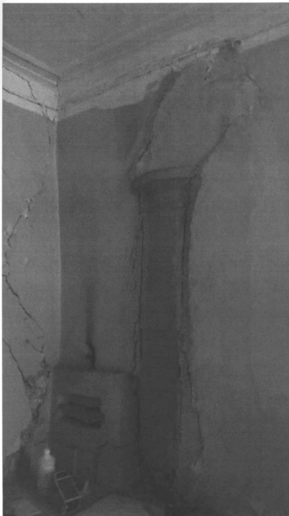
32. Сестрорецк, Дубковское шоссе, 1. 2 этаж. Печь в восточной части здания. Фото: М. И. Мильчик. 12.06.2013.
