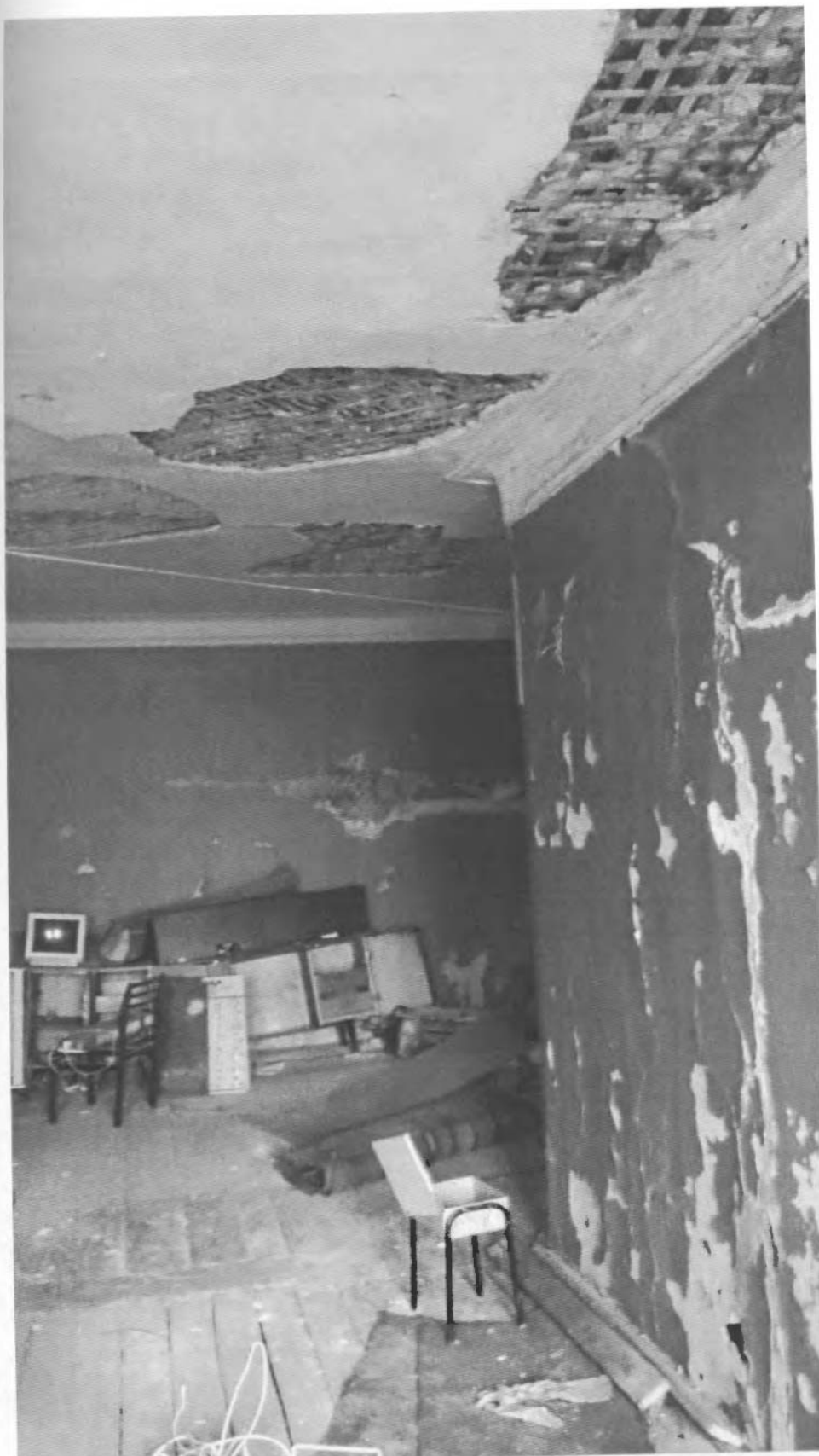
29. Сестрорецк, Дубковское шоссе, 1. 2 этаж. Помещение в центральной части здания. Вид на север. Фото: М. И. Мильчик. 12.06.2013.
