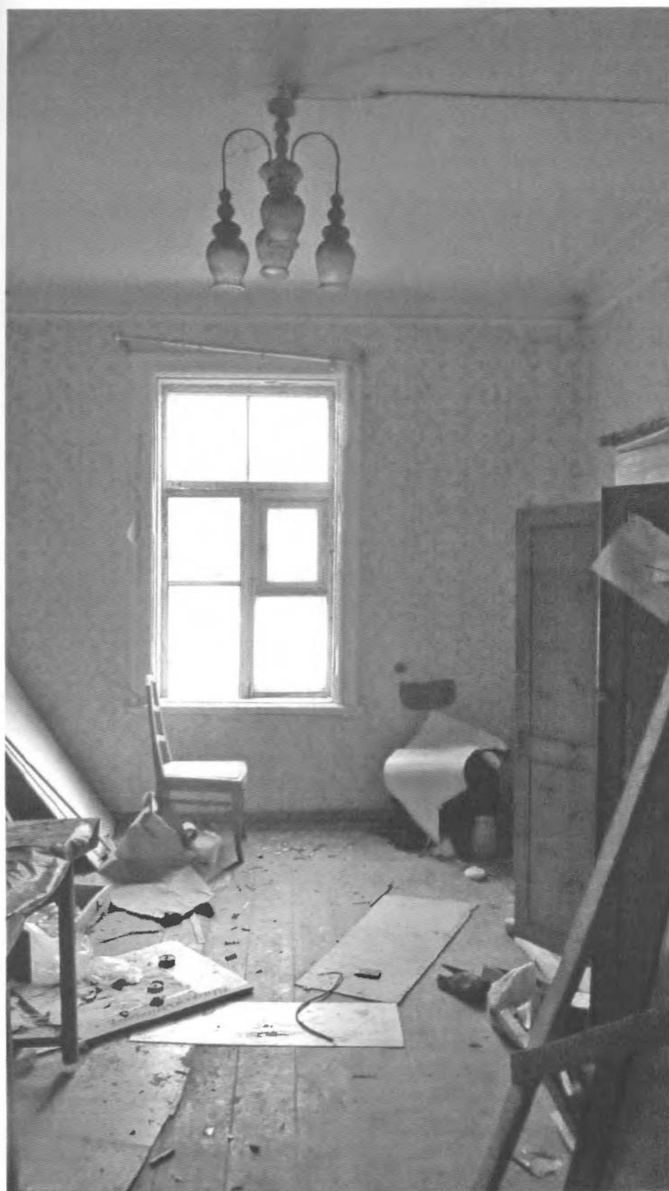
37. Сестрорецк, Дубковское шоссе, 1. 2 этаж. Помещение в восточной части здания. Вид на восток. Фото: М. И. Мильчик. 12.06.2013.
