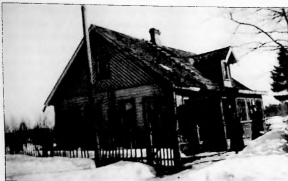
Esa ja Manda Henttisen (o.s. Mikkolainen) talo 1939. Talo oli pystyssä Emmi Mikkolaisen käydessä Raivolassa 1998. Taloon oli rakennettu toinen kerros.
