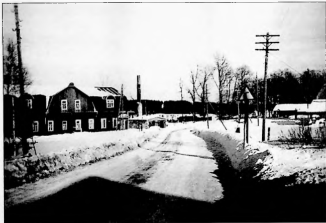
Rämön asuinrakennus tuhoutui sodassa kokonaan, kotelotehdas osittain.
