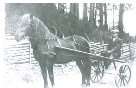
Raviurheilu kuului luonnollisesti maatalouspitäjän kuvaan. Tällaisilla rattailta ajettiin Akkalan raviradalla 1920-luvulla.
