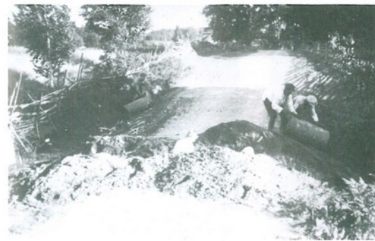
Taatilan tien rumpuja uusitaan 1930-luvulla.
