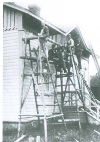
Kämärän asemarakennusta maala- taan.
