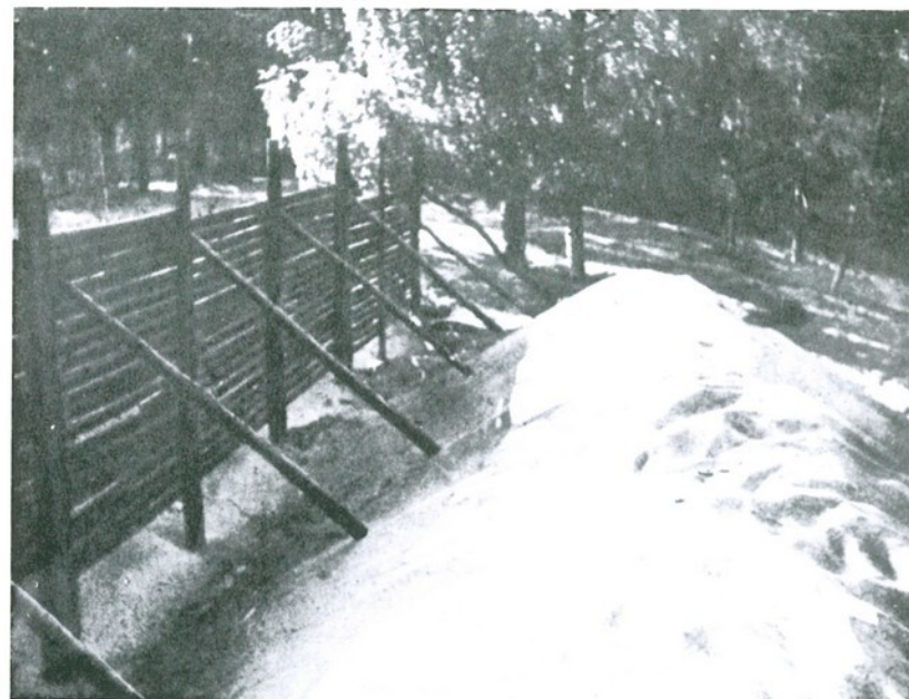
Tukevalla aidalla yritettiin pysäyttää hiekkadyynien leviäminen Muurilan lentohiekka-alueella.
