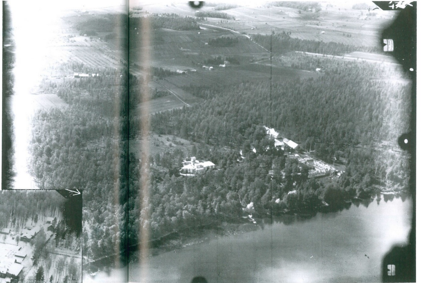
Hatjalahden järvenrantaa. Yläkuvasa etualalla jääkärien lepokoti 21. 7. 1932. Vieressä vasemmalla jääkärikoti ja edessä Saharin rakennuksia 22. 12. 1933.
