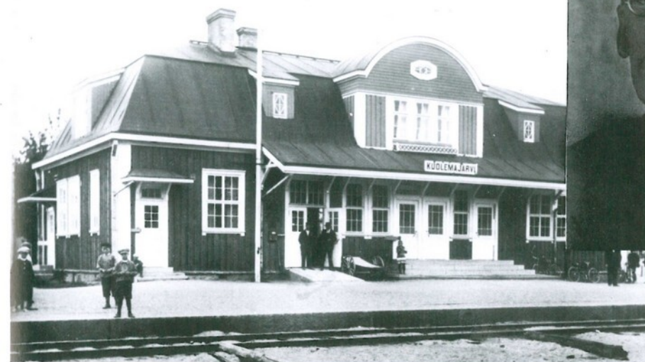
Kuolemajärven asemarakennus. Pikkukuvassa Kuolemajärven asemapäällikkö Sulo Eronen.
