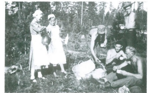
Kahvitauko linnoitustyömaalla kesällä 1939.
