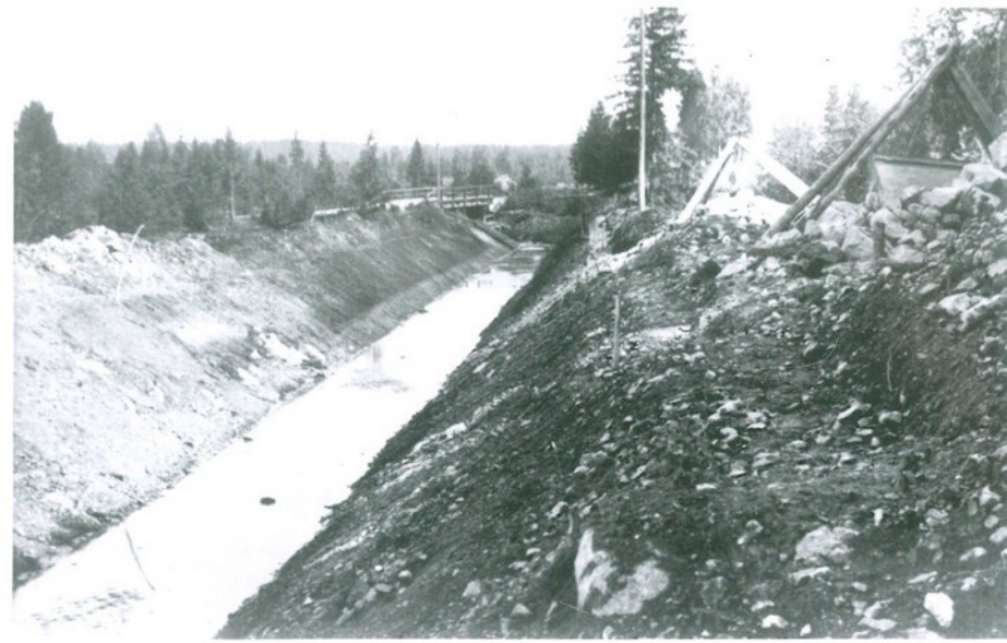
Näin siistiltä näytti Maijaanjoki, kun perkaustyö oli saatu päätökseen. Perkauksesta saatu hyötyalue – Yli 400 hehtaaria – luovutettiin hankkeessa mukana olleille 68 tilalle heinäkuussa 1939.
