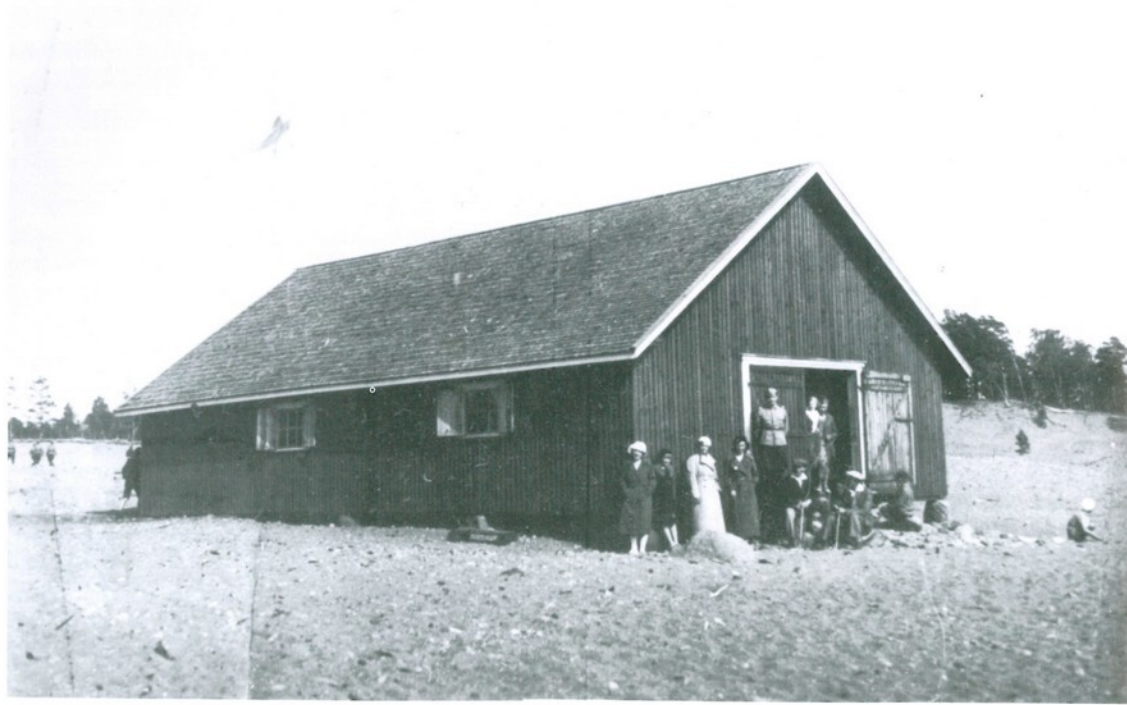
Muurilan "Hailiklubi". Meripelastusveneiden säilytysvajaa käyttivät nuoriso ja sotilaat kesäisin tanssipaikkana.
