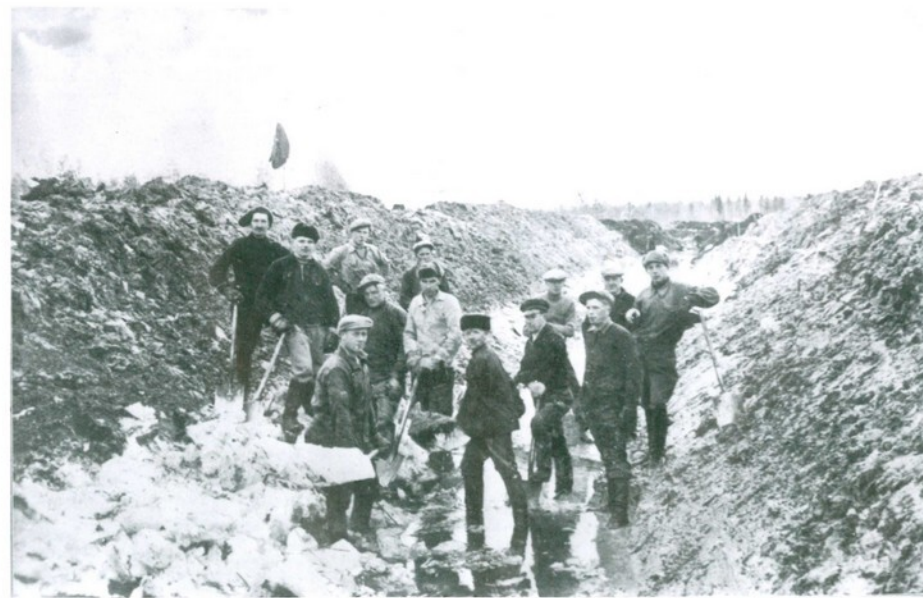
Heinäsenjoki perattiin 1930-luvun alkuvuosina. Kipinolanjärveen laskevan joen perkauksella vapautettiin yli 200 hehtaaria rantamaata haitallisista tulvista ja korkeasta pohjavedestä. Vuonna 1931 aloitettu hanke saatiin päätökseen vuonna 1934.
