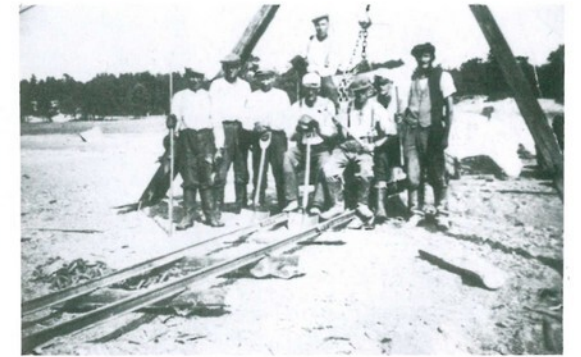
Seivästön sataman rakentamista helpotti rautaraide.
