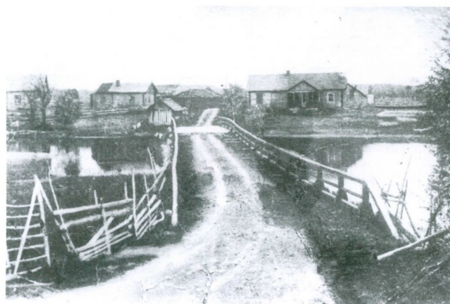
Työppölän vanha silta.
