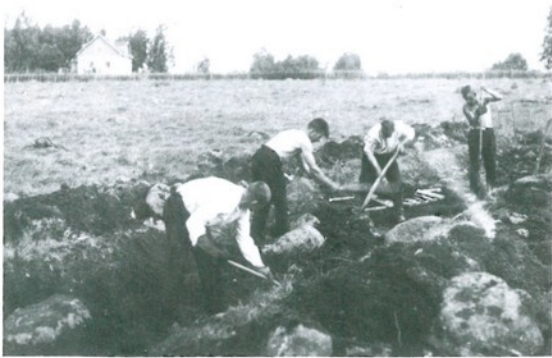
Salaojituksella nostettiin maan tuottoa. Putket upotettiin mm. Tatu Muurisen laitumelle Inkilässä.
