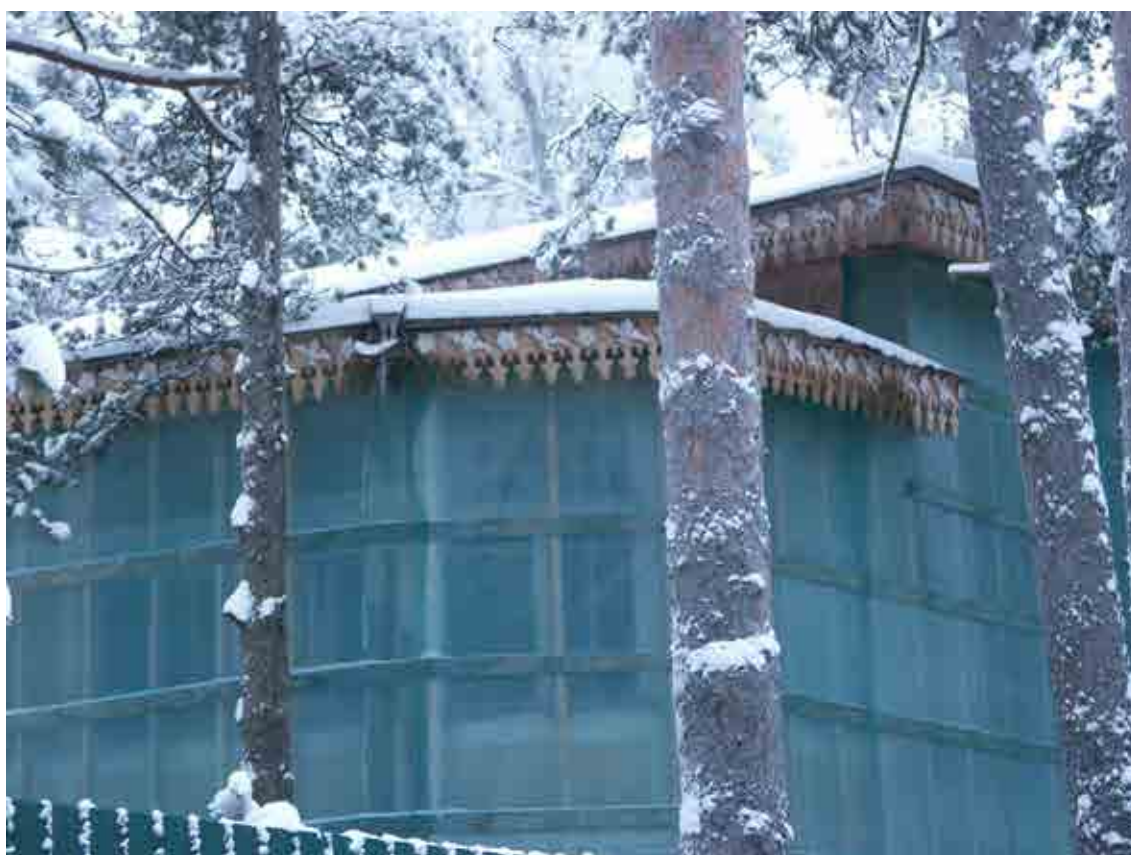
Илл. 02. Северо-западный и северо-восточный фасады. Фрагмент 2-го этажа. Вид с Морской ул. Съемка 23.12.2015 г., Трушковский В.Э.
