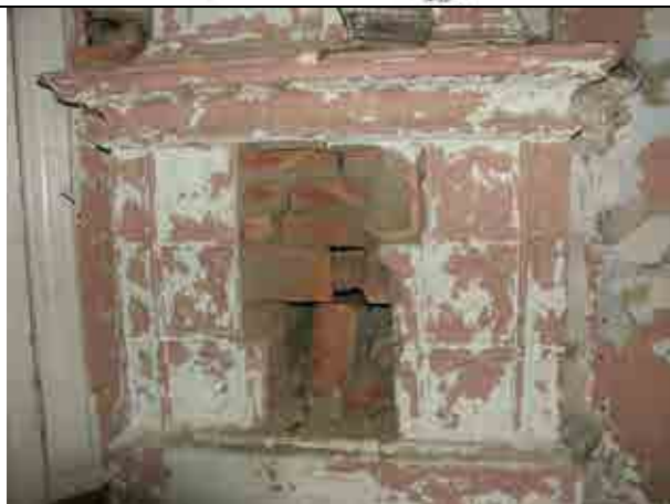
Илл. 07. 1-й этаж. Пом. 5/13,2. Печь угловая. Фрагмент. Съемка 23.12.2015 г., В.Э. Трушковский.
