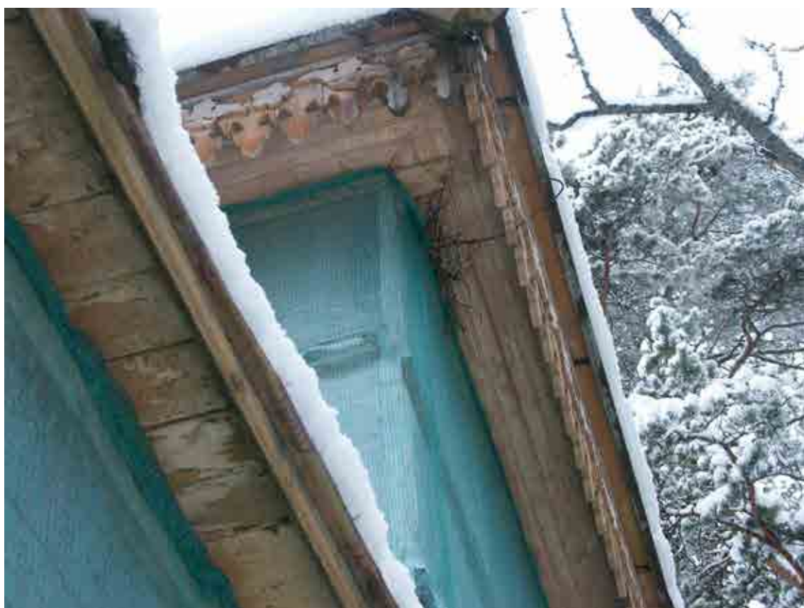
Илл. 12. Северо-восточный фасад. Фрагмент. Кровельный свес. Съемка 23.12.2015 г., Трушковский В.Э.
