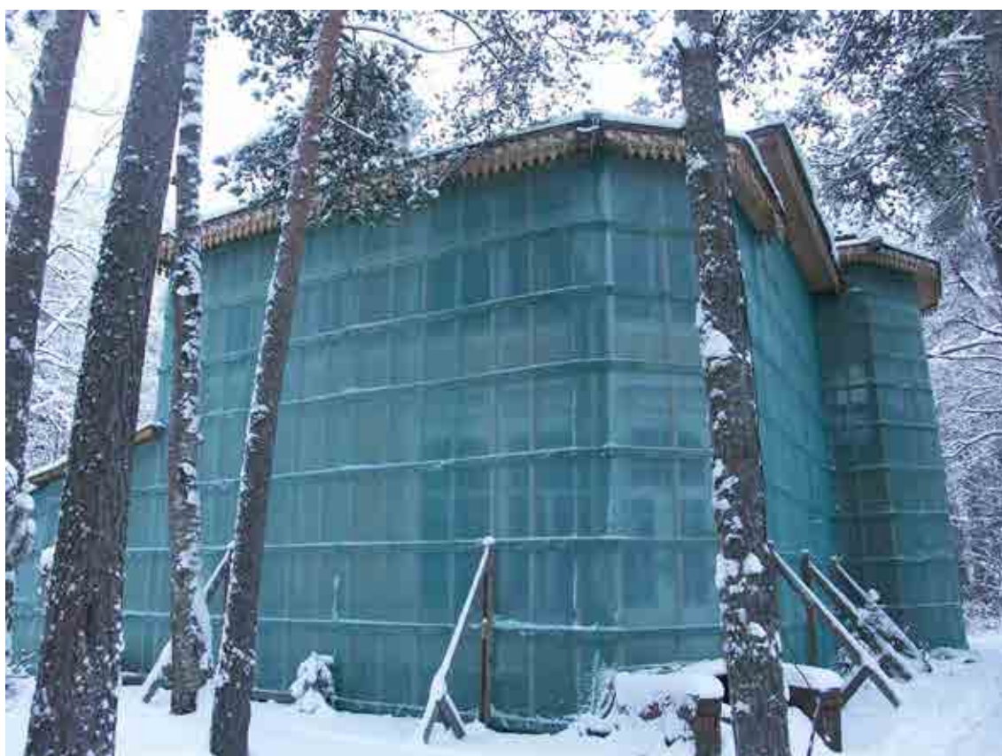
Илл. 04. Северо-западный и северо-восточный фасады. Вид с Морской ул. Съемка 23.12.2015 г., Трушковский В.Э.
