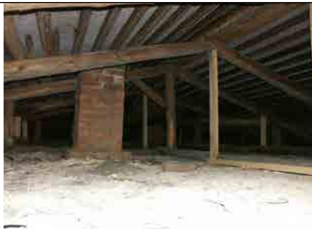
Илл. 43. Чердачное помещение. Съемка 23.12.2015 г., В.Э. Трушковский.
