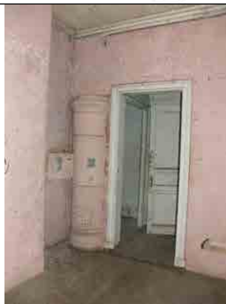
Илл. 36. 2-й этаж. Пом. 9/15,6. Печка. Съемка 23.12.2015 г., В.Э. Трушковский.
