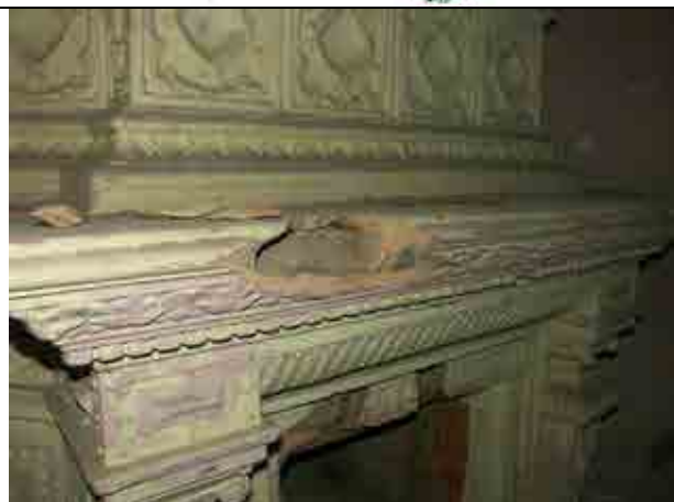
Илл. 16. 1-й этаж. Пом. 8/16,2. Угловой камин. Фрагмент. Съемка 23.12.2015 г., В.Э. Трушковский.
