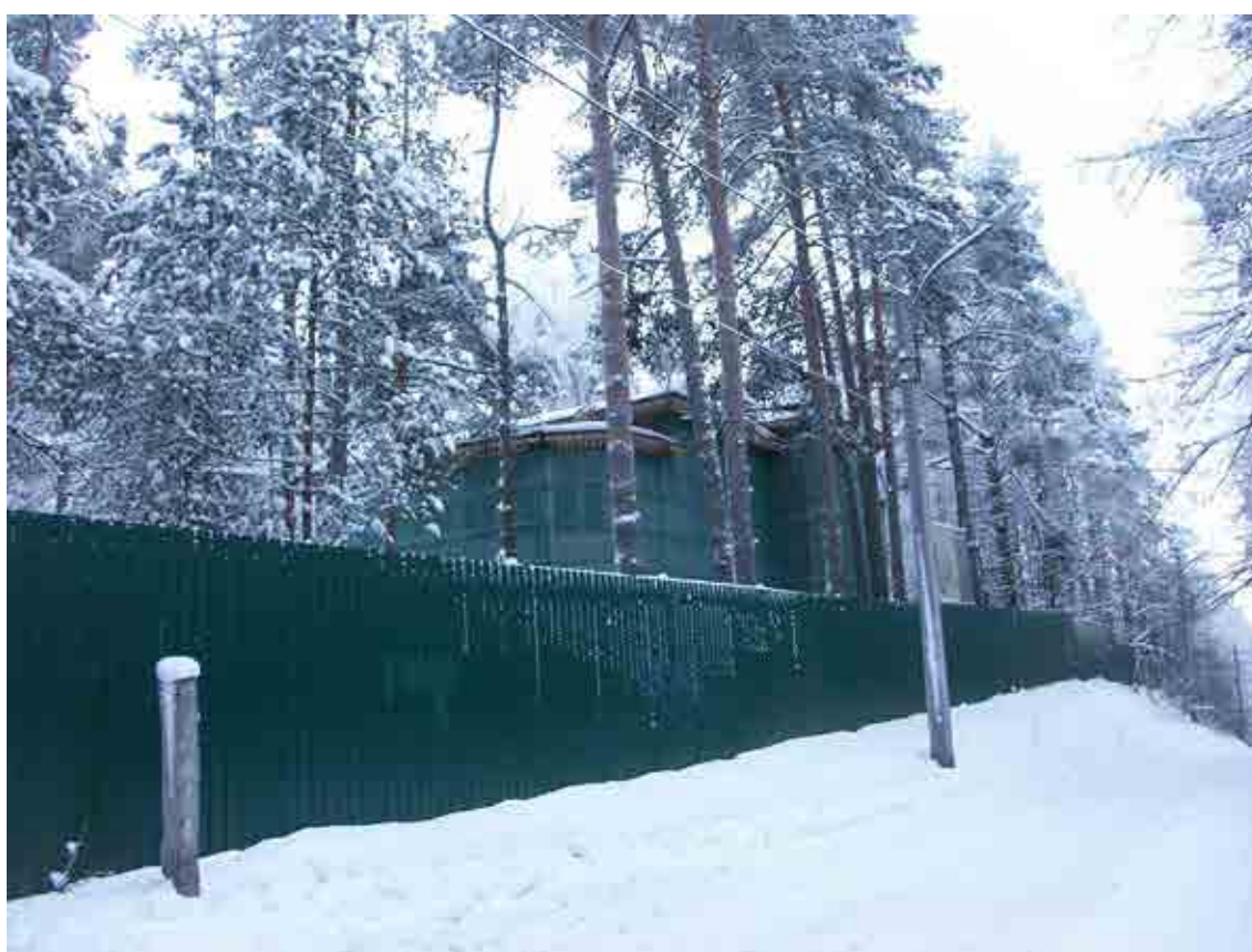
Илл. 01. Северо-западный и северо-восточный фасады. Вид с Морской ул. Съемка 23.12.2015 г., Трушковский В.Э.
