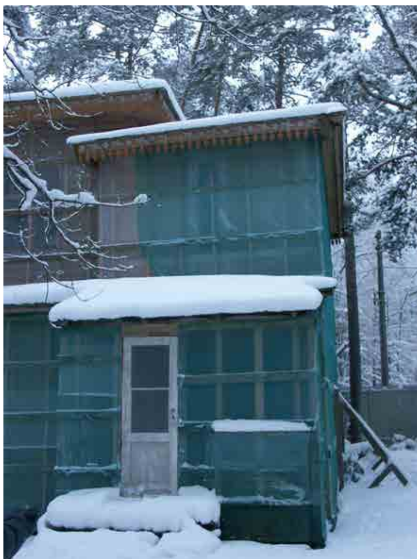
Илл. 13. Юго-восточный фасад. Фрагмент. Съемка 23.12.2015 г., Трушковский В.Э.
