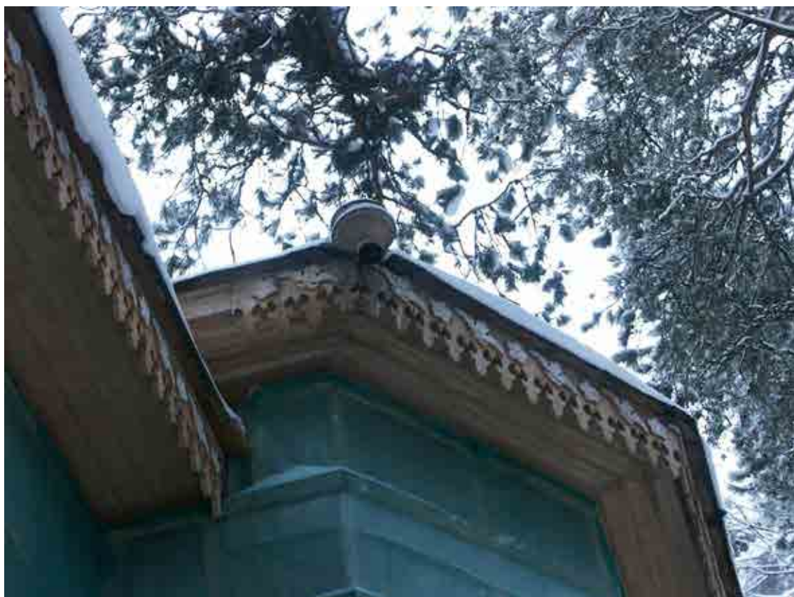
Илл. 06. Северо-западный фасад. Фрагмент. Съемка 23.12.2015 г., Трушковский В.Э.
