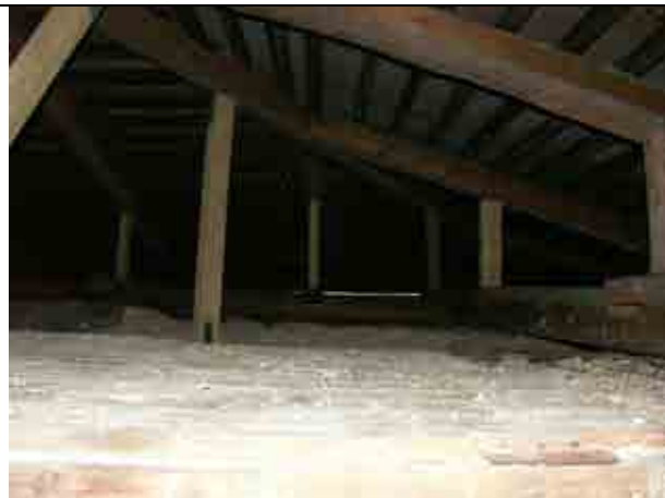
Илл. 44. Чердачное помещение. Съемка 23.12.2015 г., В.Э. Трушковский.
