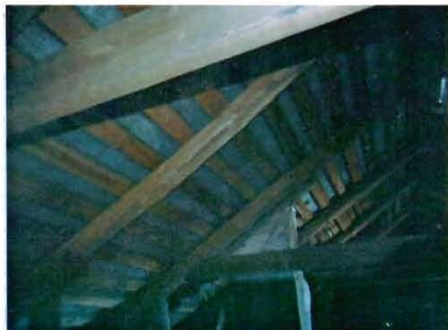
14. Стропильная система.
