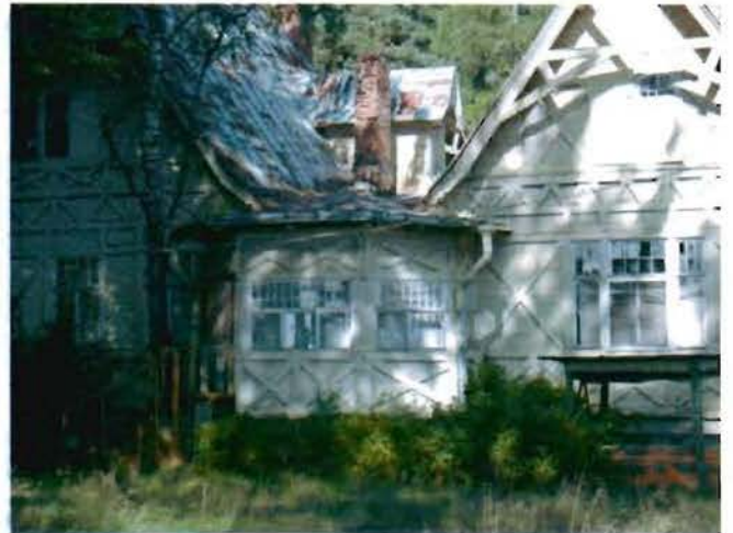
6. Эркер южного фасада здания.
