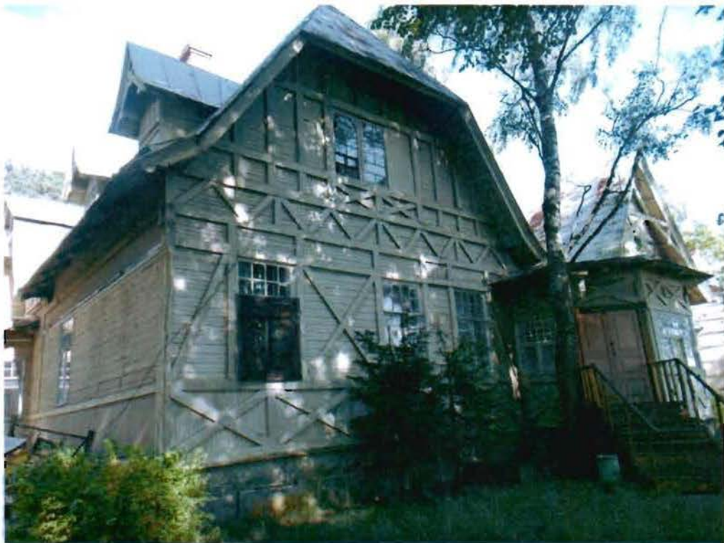
1. Фрагмент южного фасада здания. Вид с юго-запада.
