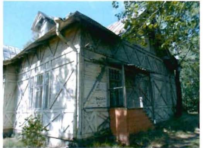
4. Восточный фасад. Вид с юго-востока.
