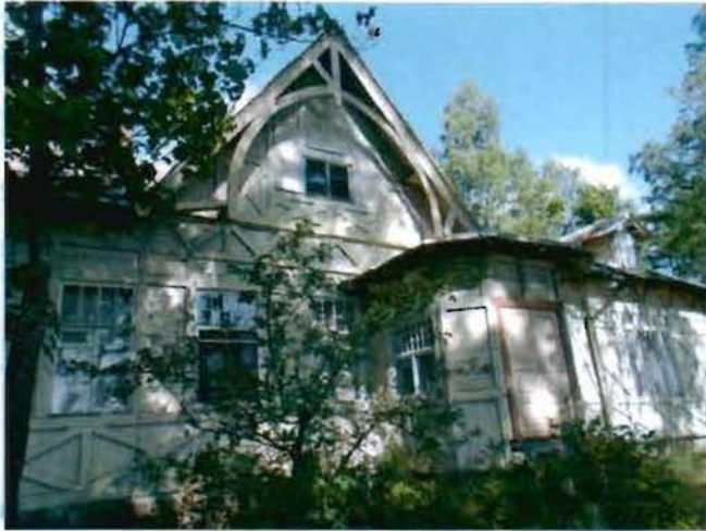
3. Фрагмент южного фасада.
