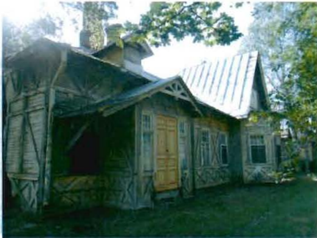
5. Общий вид с северо-востока.
