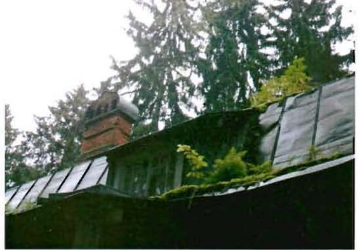
6. Металлическое покрытие кровли
