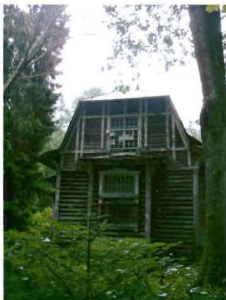
1. Северо-западный фасад здания
