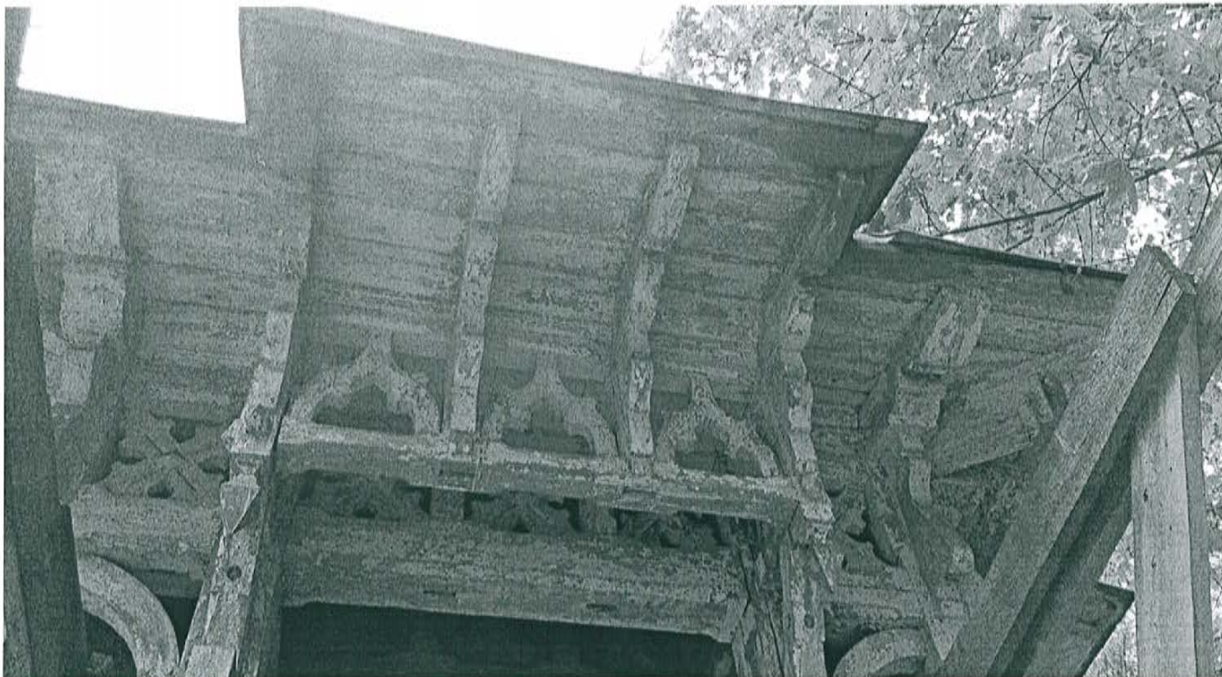
5. Фрагмент карнизного свеса
