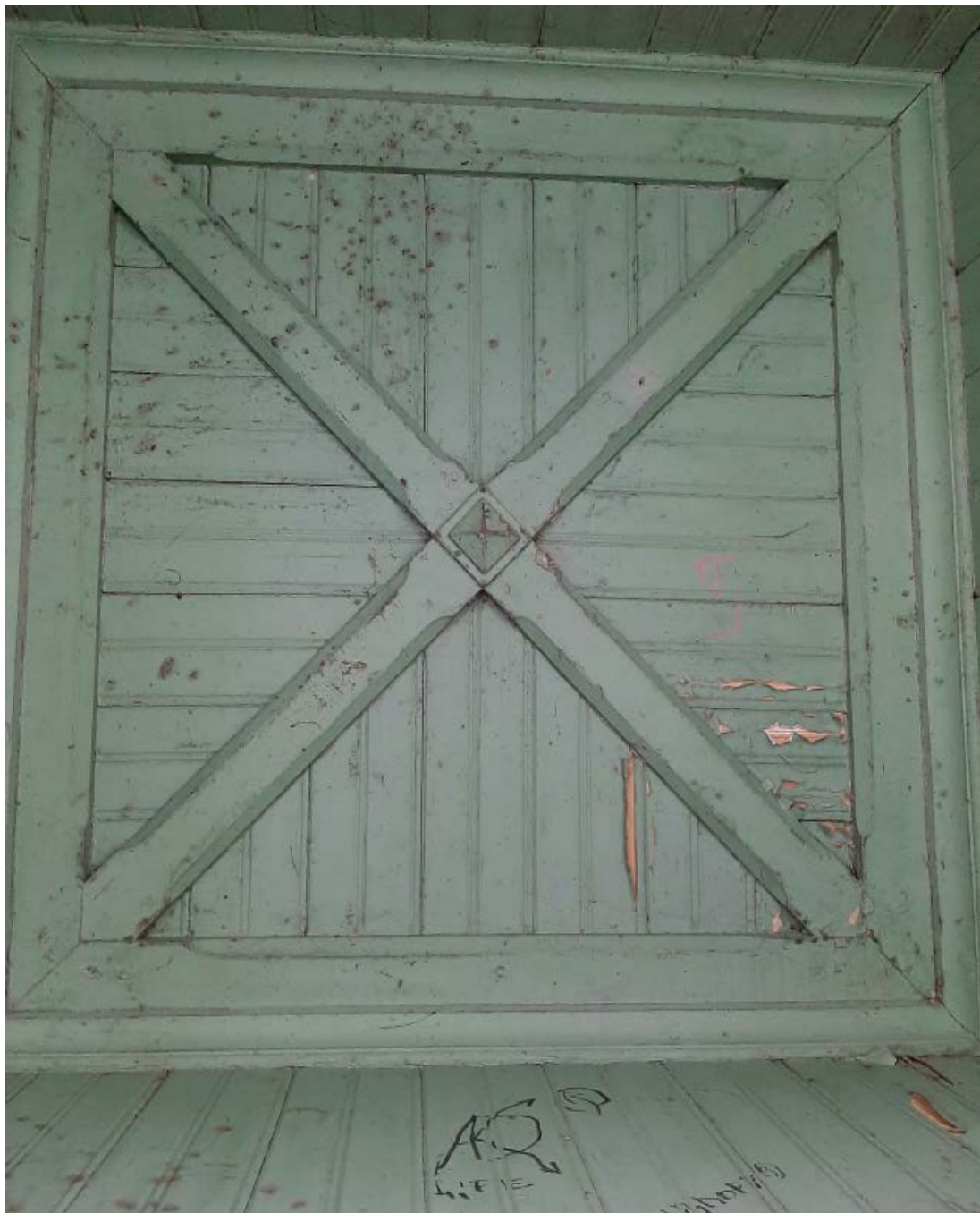
12. Подшивка потолка перекрытия. 01.09.2020
