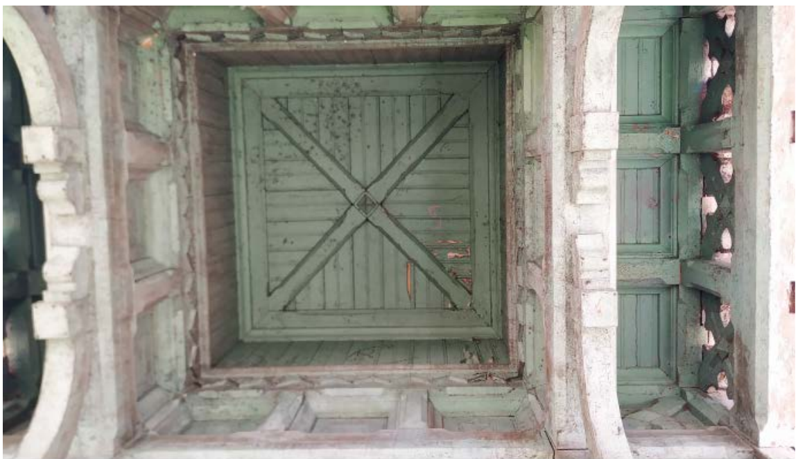
11. Подшивка потолка перекрытия. 01.09.2020
