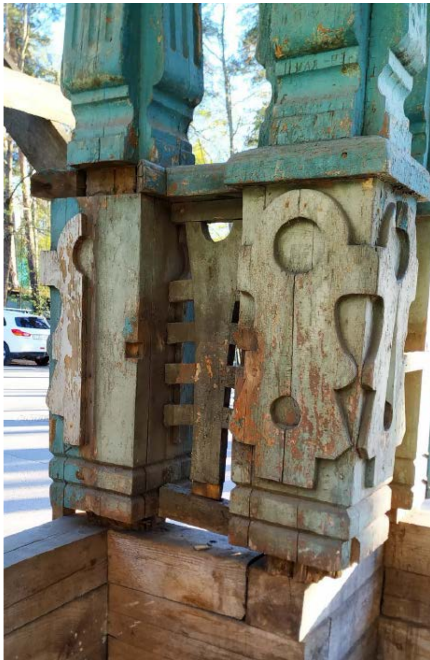
8. Фрагмент нижней части пилонов изнутри с угла ул. Лесной и Андреевой. 01.09.2020
