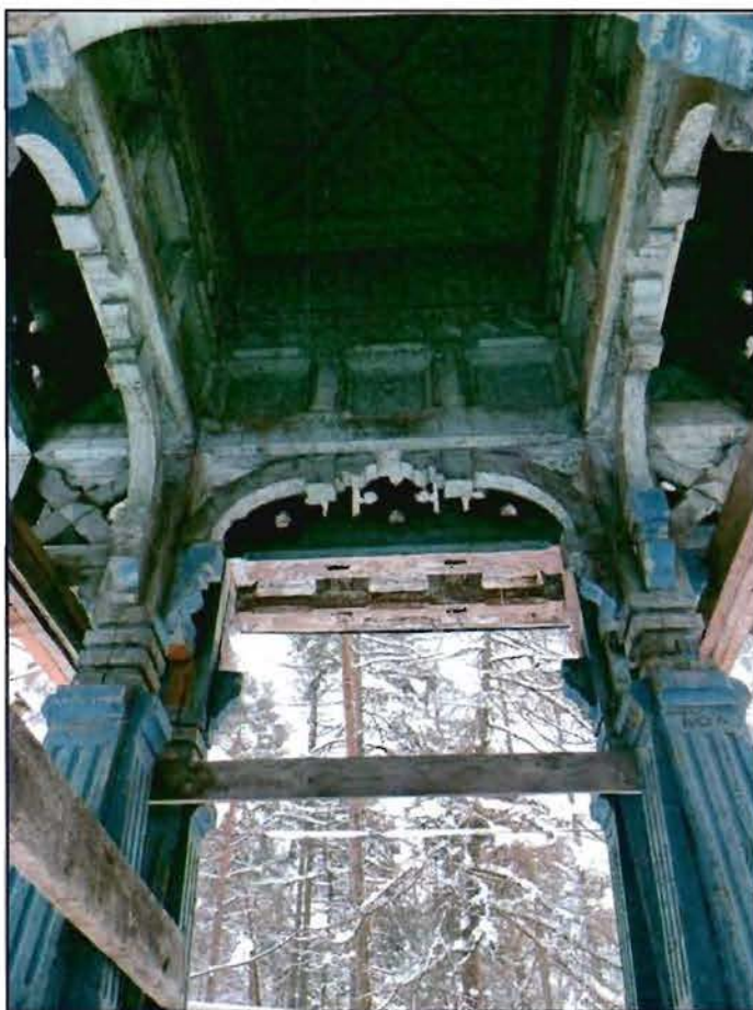
4. Вид на перекрытие снизу вверх.
