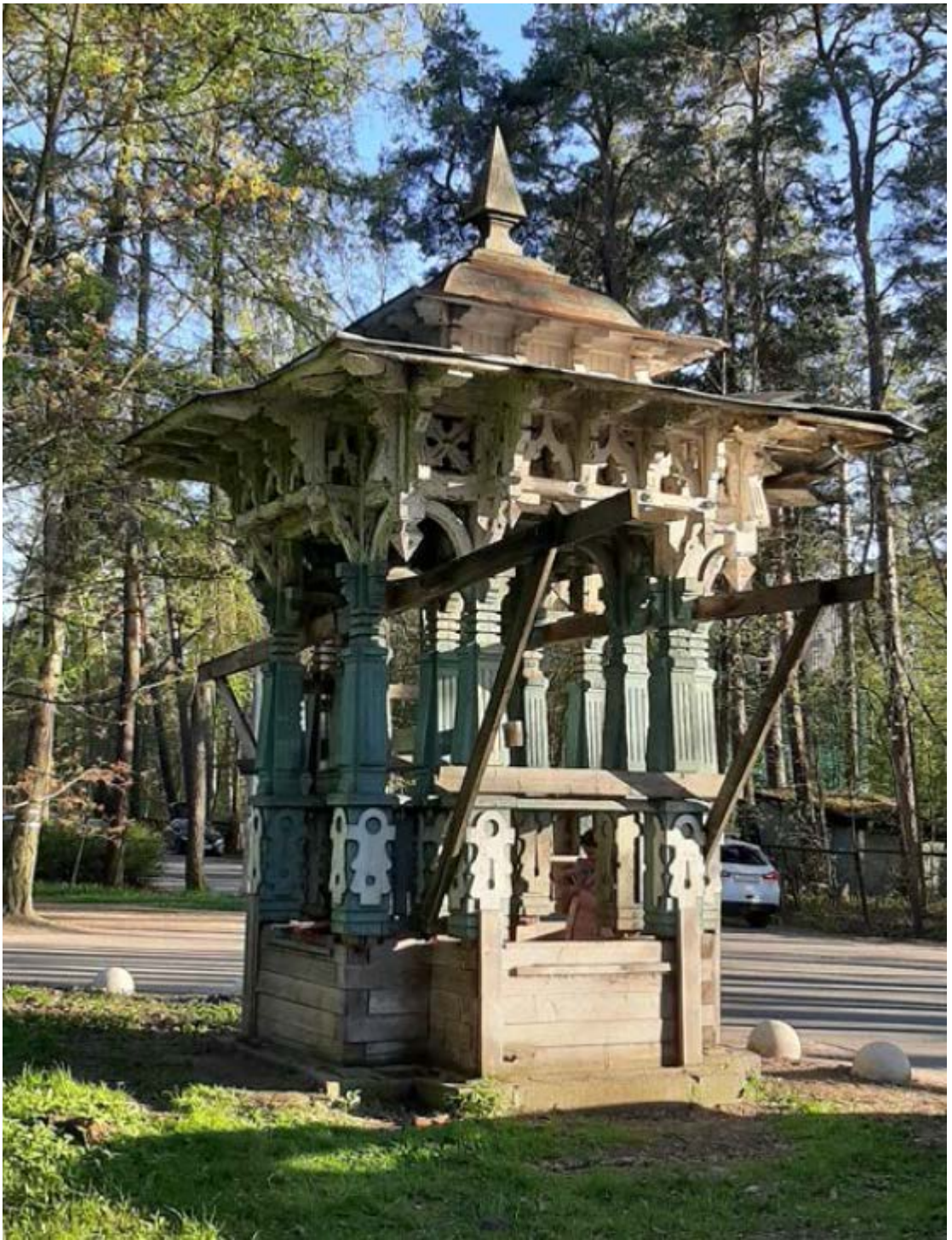
20. Беседка после проведения противоаварийных мероприятий. Июнь. 2020 г.
