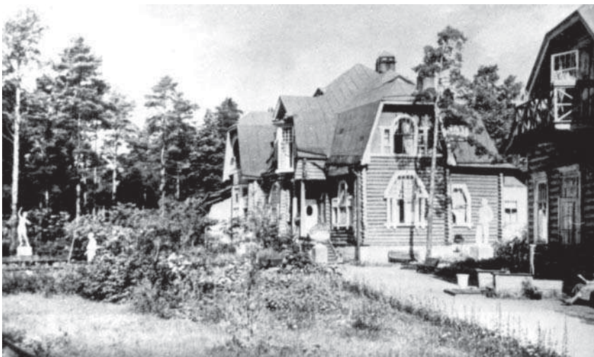
Дом отдыха работников культуры (ул. Горького, 20)
