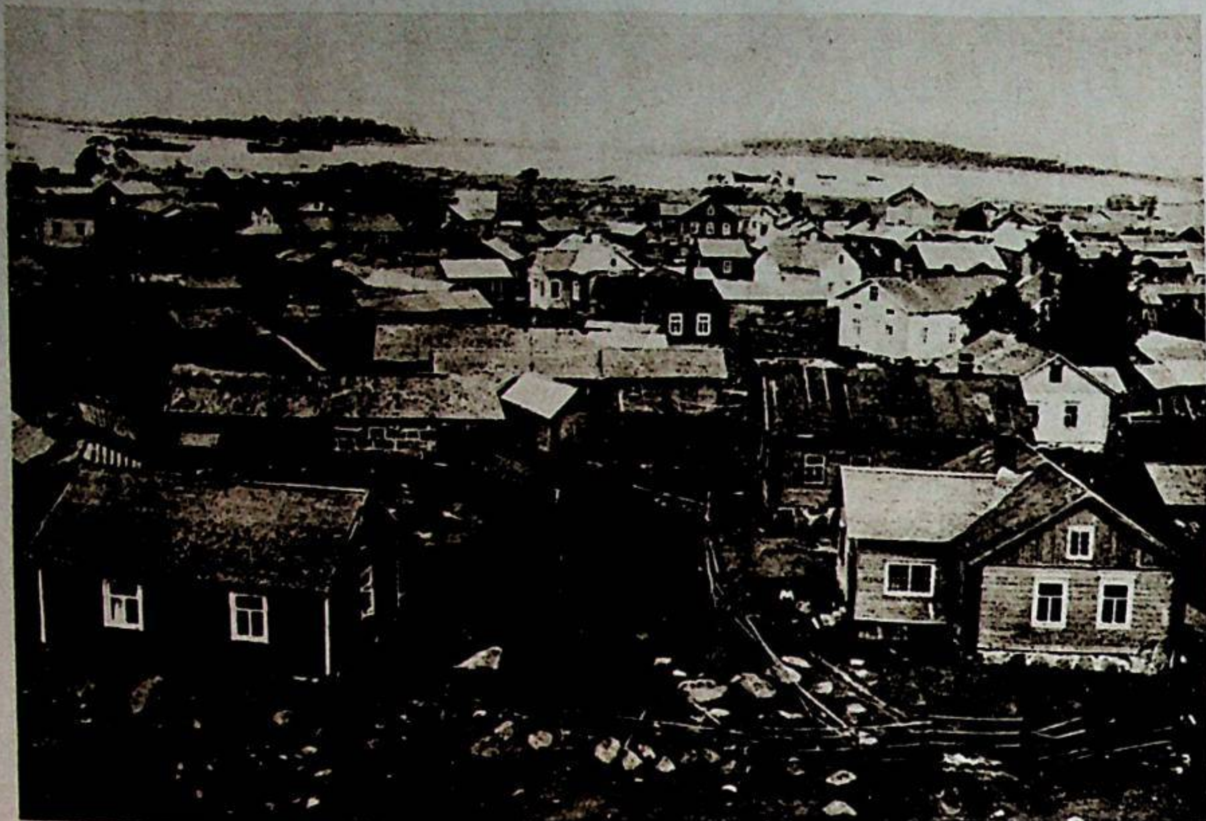
Yleisilmäys Lavansaaren kirkonkylään. Taustalla satama-alue pitkän niemen suojassa.
