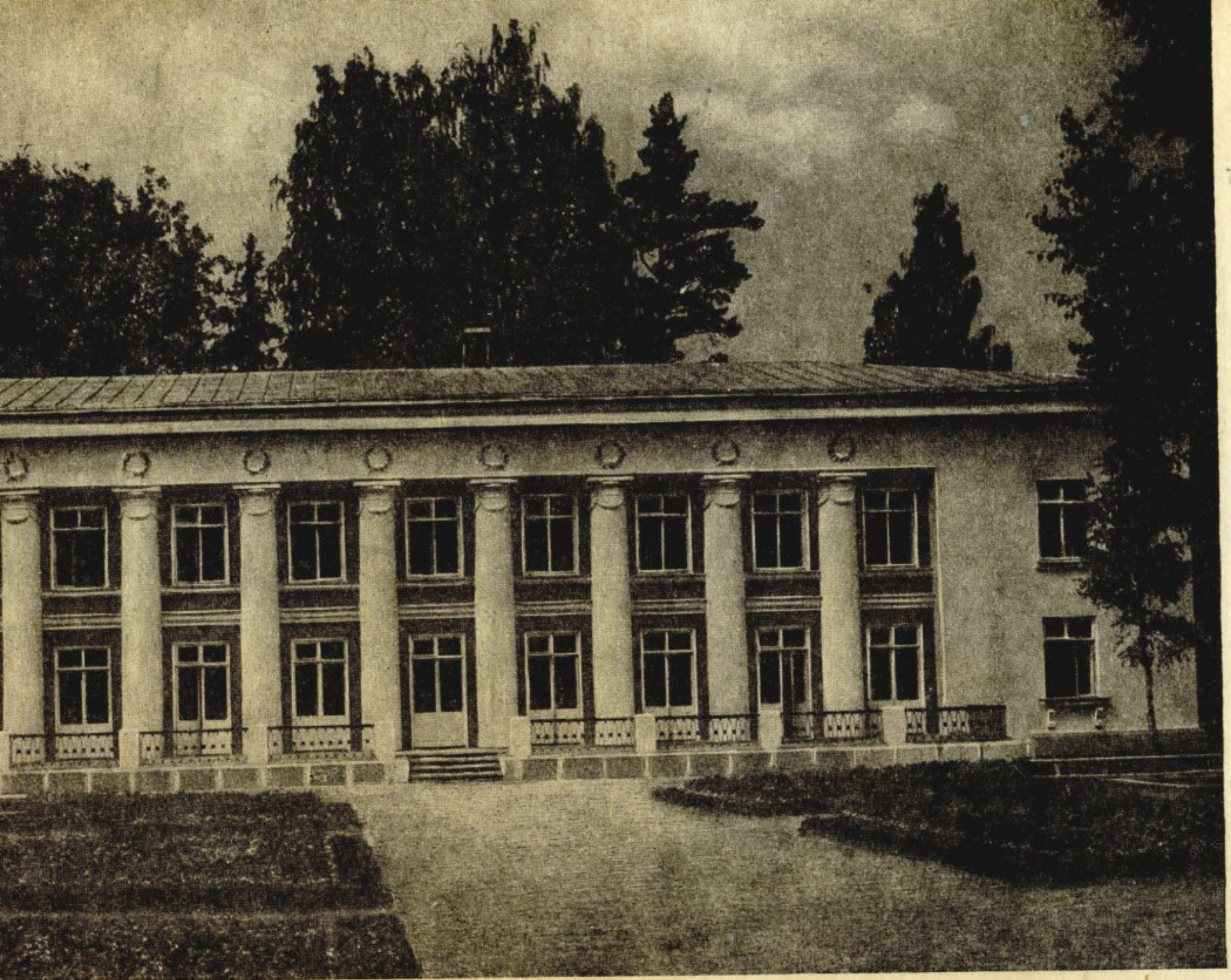
Здание детского сада Куйбышевского района в Ушкове (архитектор В. Д. Кирхоглани)
