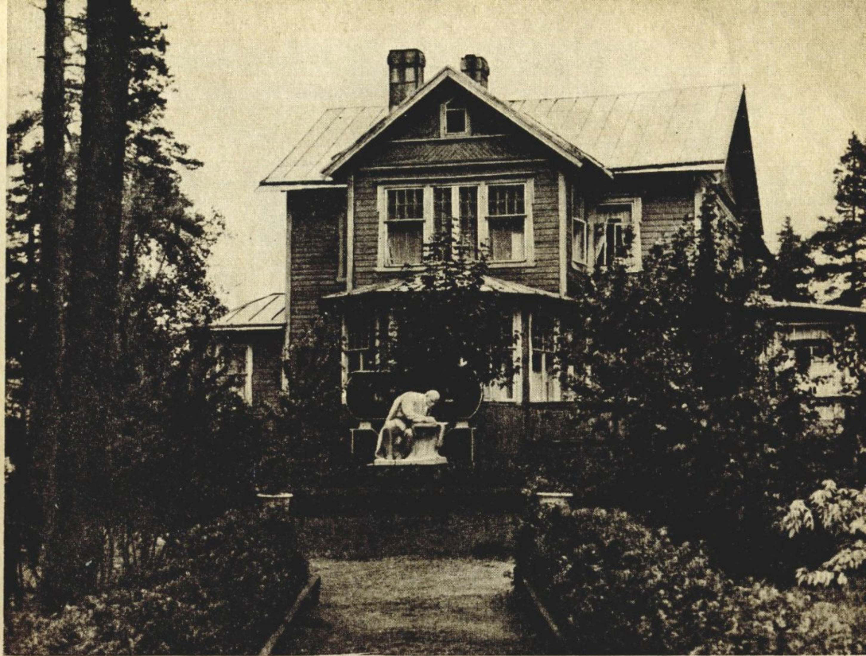
Дом отдыха «Приморье». Одно из зданий
