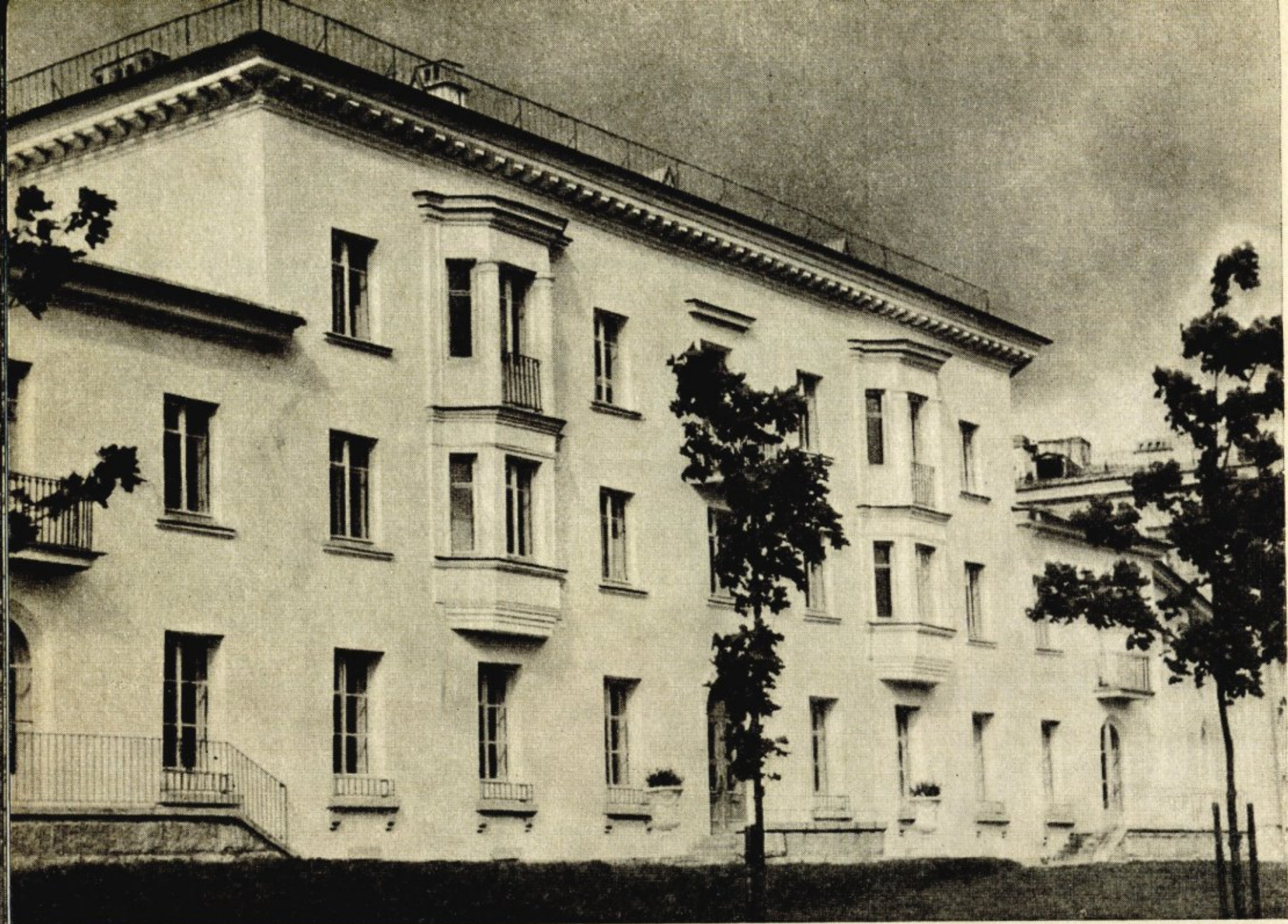
Жилой дом в Зеленогорске
